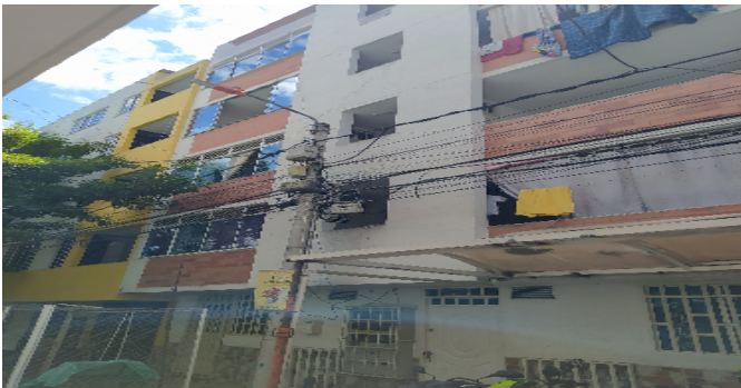
Fachada del Inmueble
