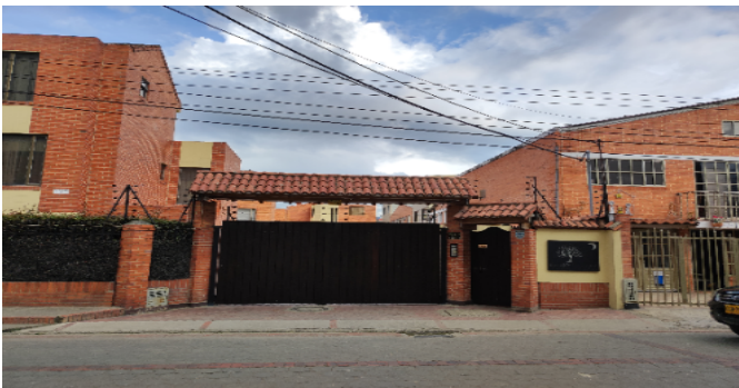
Fachada del Inmueble
