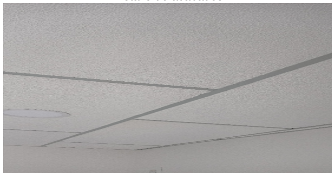
Detalle de acabados
