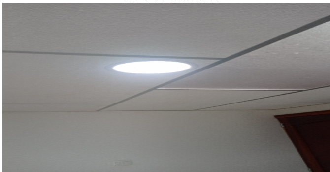
Detalle de acabados
