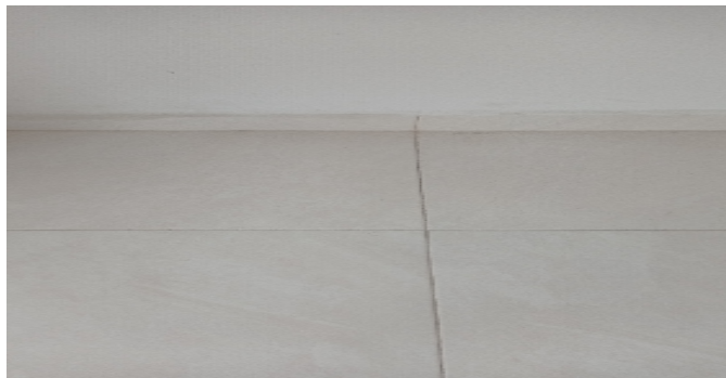
Detalle de acabados
