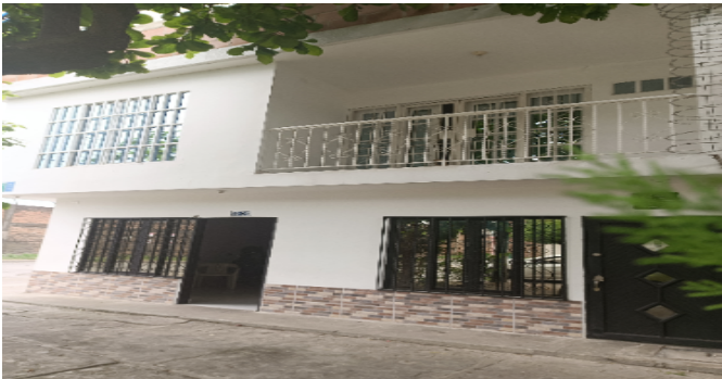
Fachada del Inmueble
