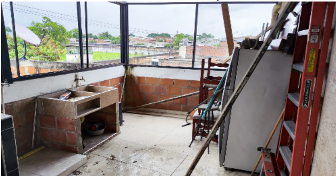
APTO 3 zona de ropas
