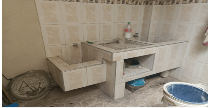
APTO 1 zona de ropas
