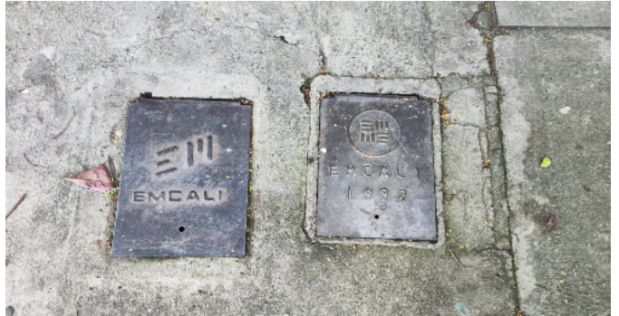
Contador de Agua
