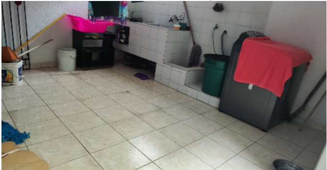
APTO 5 zona de ropas
