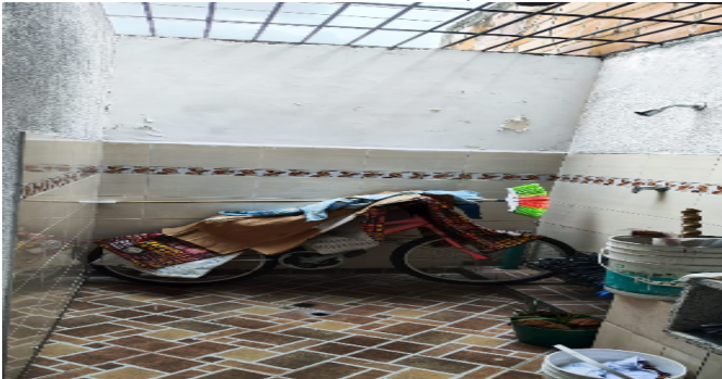
APTO 2 zona de ropas
