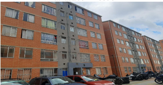
Fachada del Inmueble
