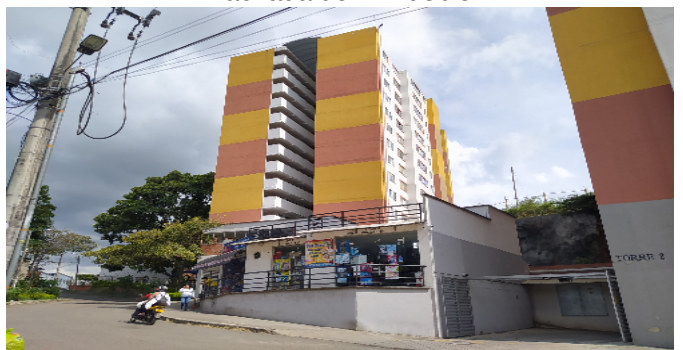
Fachada del Inmueble
