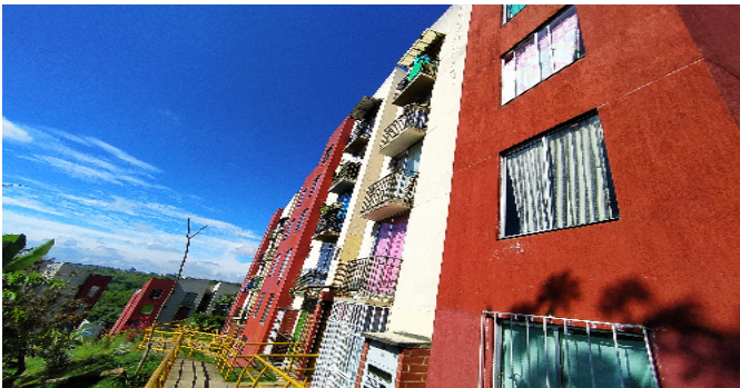
Fachada del Inmueble
