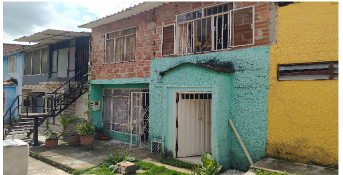
Fachada del Inmueble
