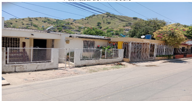
Fachada del Inmueble
