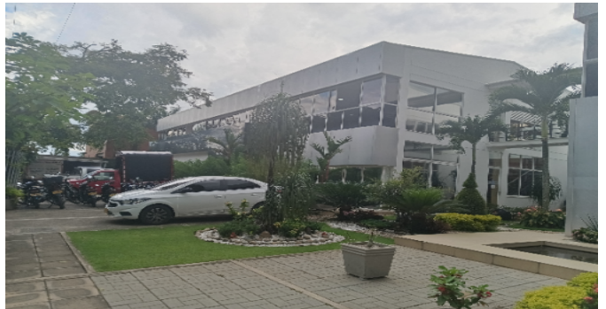
Fachada del Inmueble
