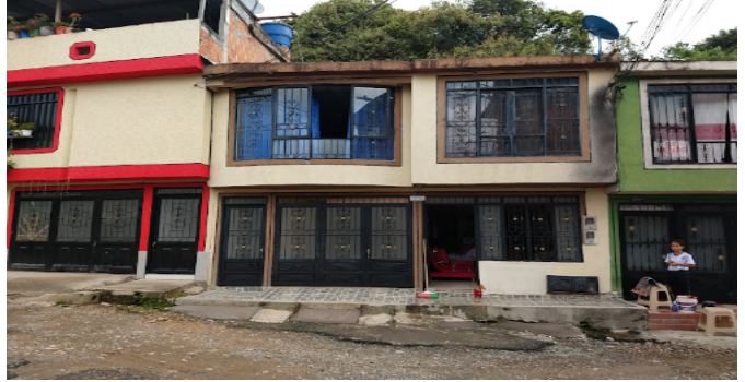
Fachada del Inmueble
