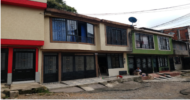
Fachada del Inmueble
