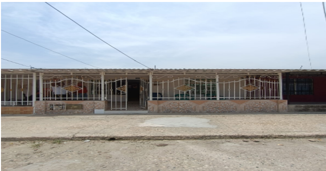
Fachada del Inmueble
