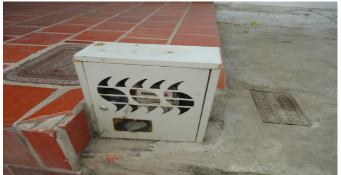
Contador de Gas
