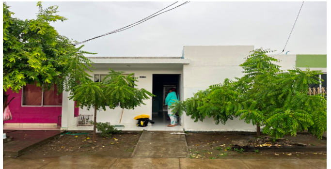
Fachada del Inmueble
