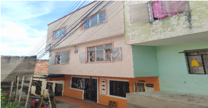
Fachada del Inmueble
