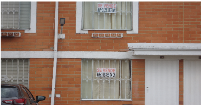
Fachada del Inmueble
