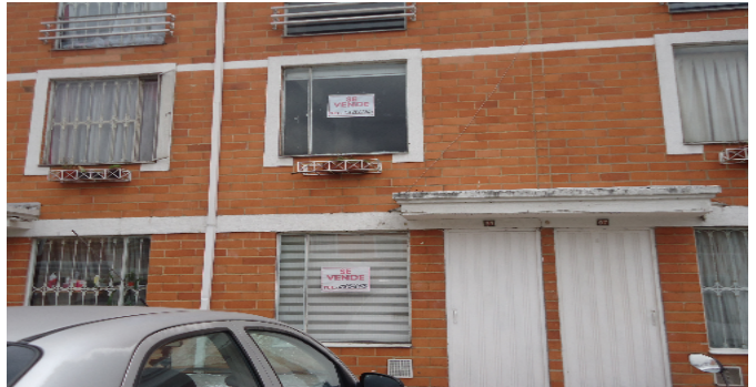
Fachada del Inmueble
