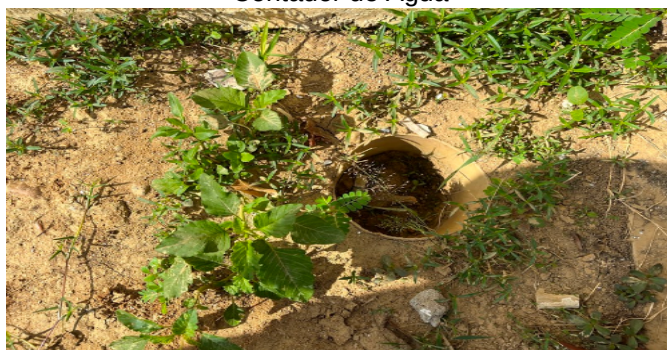
Contador de Agua
