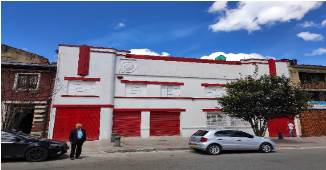
Fachada del Inmueble
