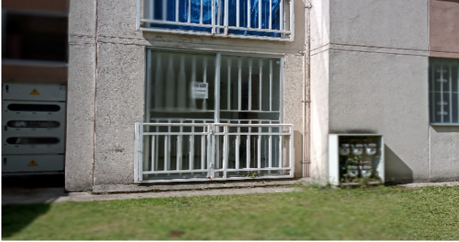
Fachada del Inmueble
