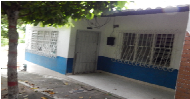
Fachada del Inmueble
