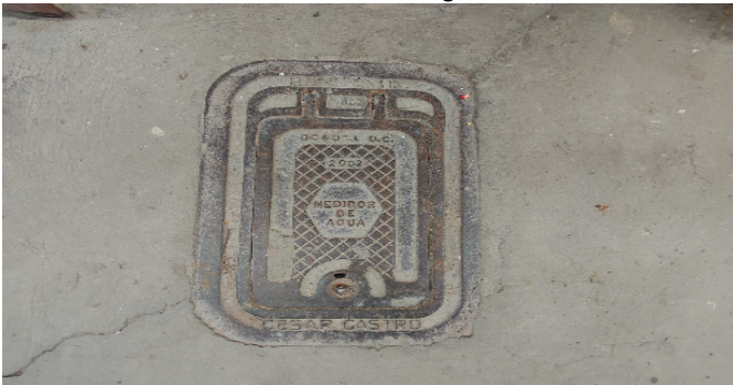
Contador de Agua
