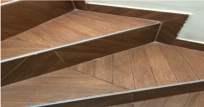
Detalle de acabados
