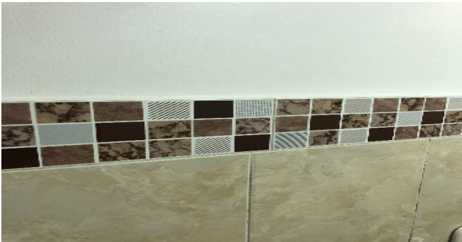
Detalle de acabados
