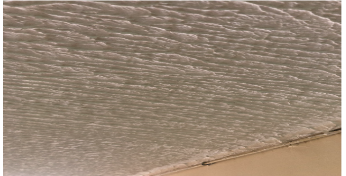
Detalle de acabados
