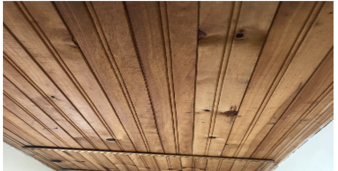
Detalle de acabados
