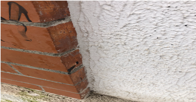
Detalle de acabados
