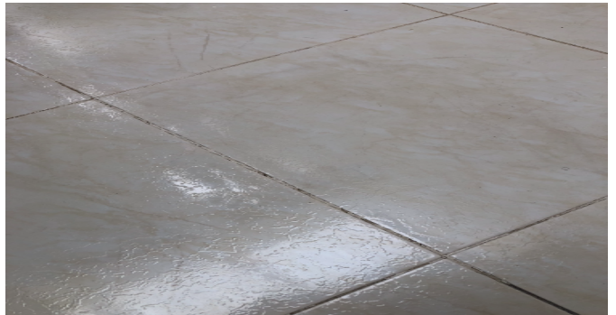
Detalle de acabados
