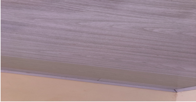
Detalle de acabados
