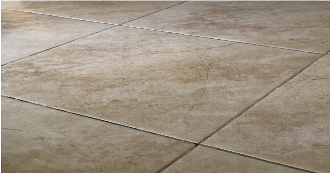
Detalle de acabados
