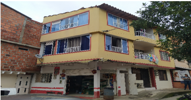
Fachada del Inmueble
