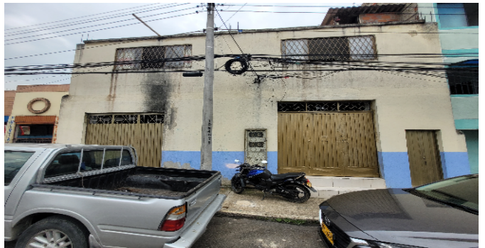
Fachada del Inmueble
