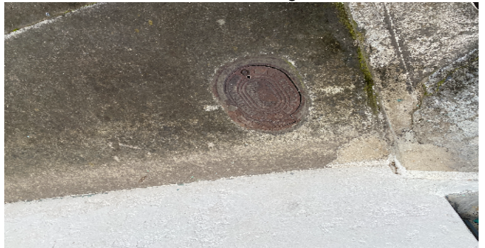
Contador de Agua
