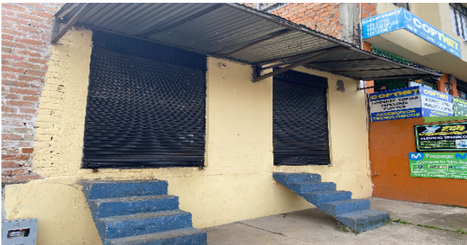
Fachada lado derecho
