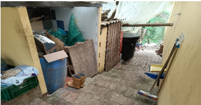
Zona de maquinas
