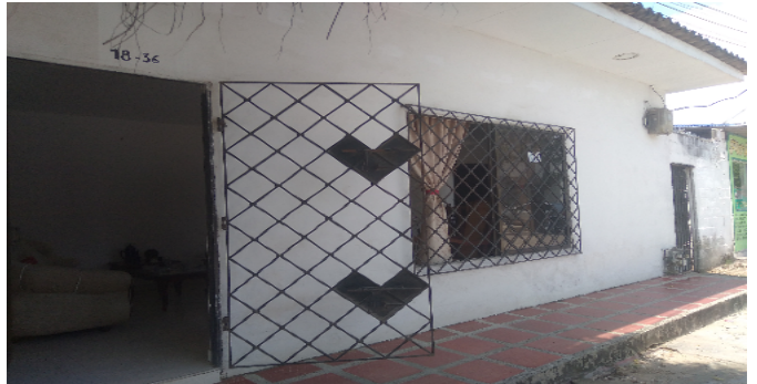
Fachada del Inmueble
