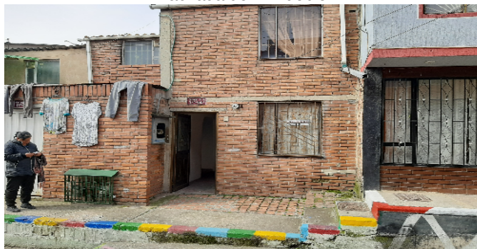
Fachada del Inmueble
