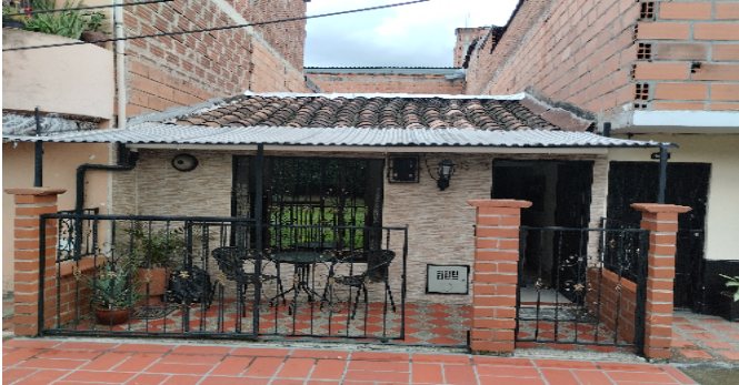
Fachada del Inmueble
