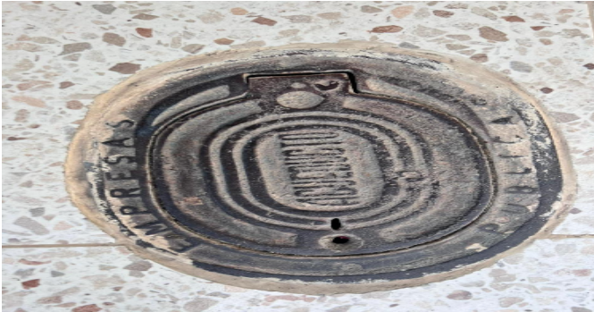
Contador de Agua
