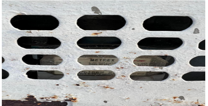
Contador de Gas
