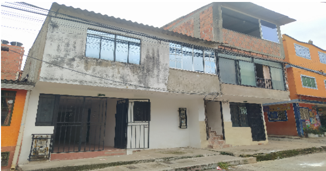
Fachada del Inmueble
