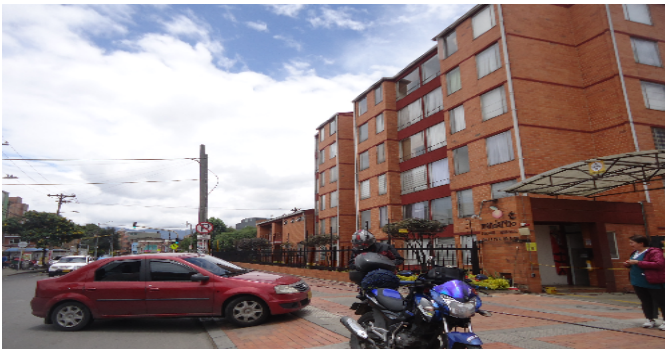
Fachada del Inmueble
