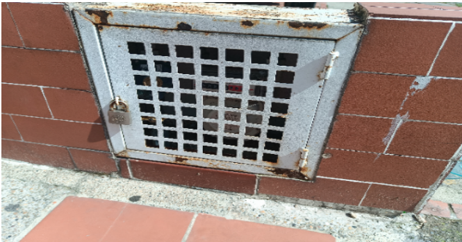
Contador de Gas
