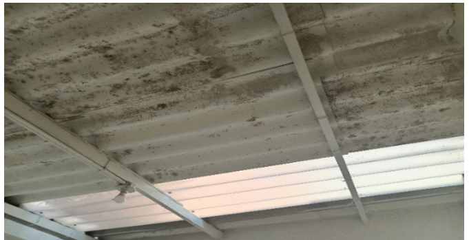
Detalle de acabados
