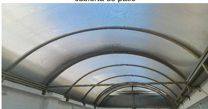
cubierta de patio
