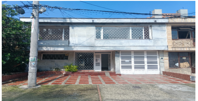
Fachada del Inmueble
