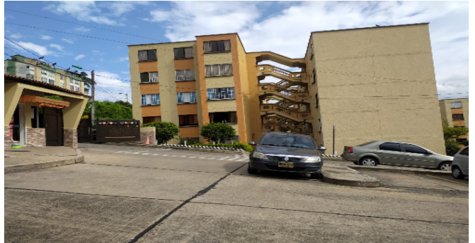
Fachada del Inmueble
