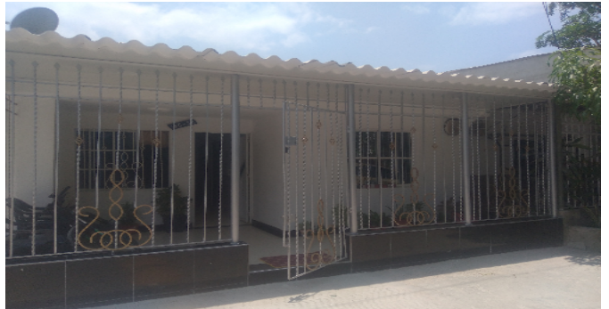
Fachada del Inmueble
