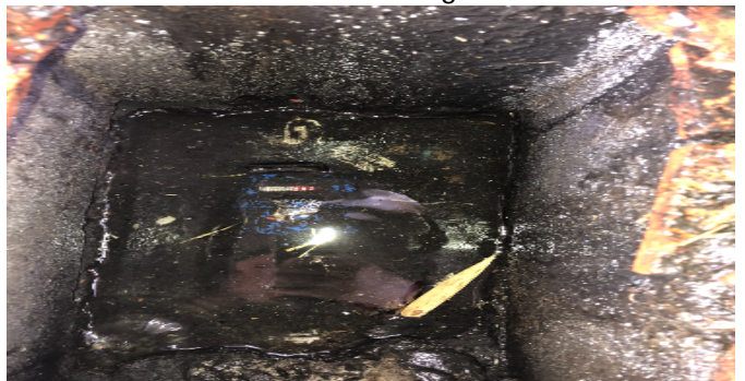
Contador de Agua
