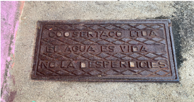
Contador de Agua
