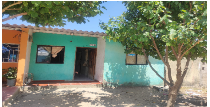
Fachada del Inmueble
