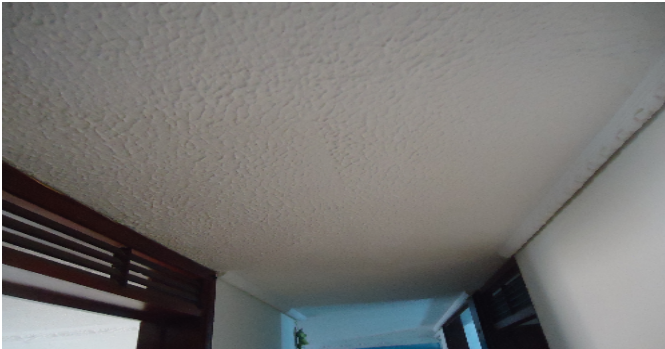
Detalle de acabados
