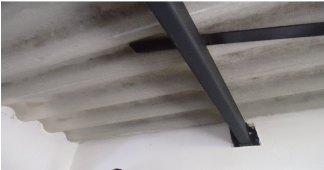
Detalle de acabados
