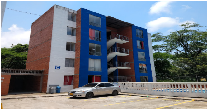
Fachada del Inmueble
