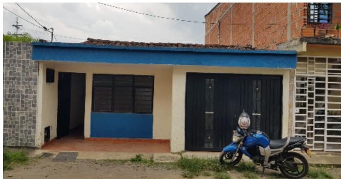
Fachada del Inmueble
