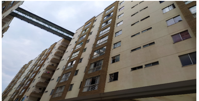
Fachada del Inmueble
