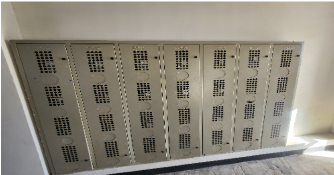
Contador de Gas
