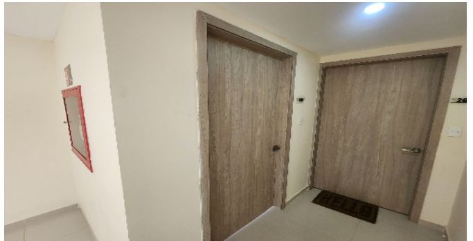
Fachada del Inmueble
