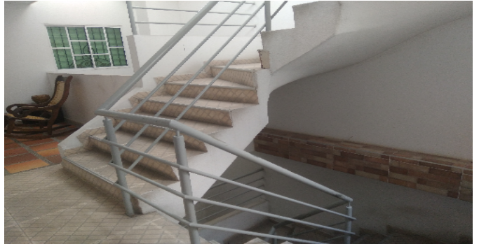
Escalera comn CJ
