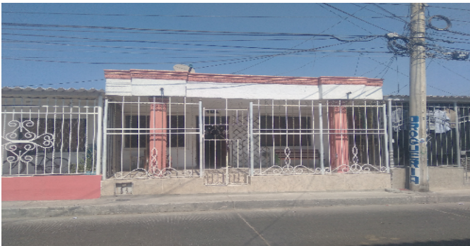
Fachada del Inmueble
