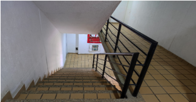
Escalera común - CJ
