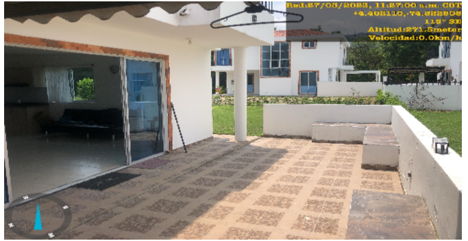
PATIO AMOBLADO EN MAMPOSTERIA
