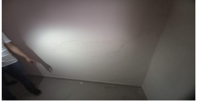
Detalle de acabados
