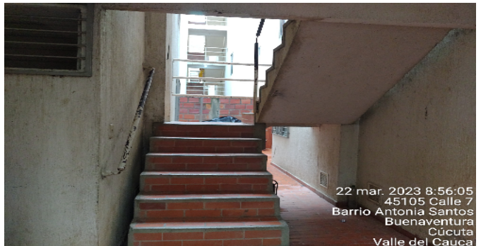
Escalera común - CJ
